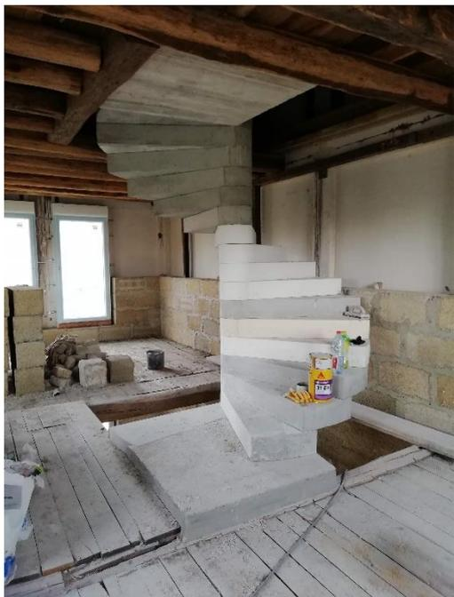
Nous avons revu notre concept et opté pour une maison en structure béton préfabriqué et une isolation en bloc de béton de chanvre. Les formes isolantes plancher et plafond sont en chanvre coulé sur place.
